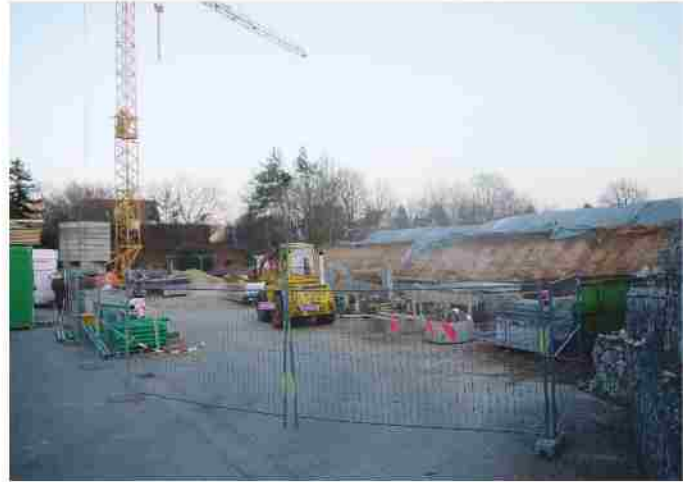
Bauarbeiten am neuen BRK-Haus Stein im rückwärtigen Bereich der Feuerwache.
