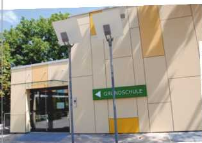
Generalsanierung der Schulturnhalle sowie der Grund- und Mittelschule für über 8 Mio €
