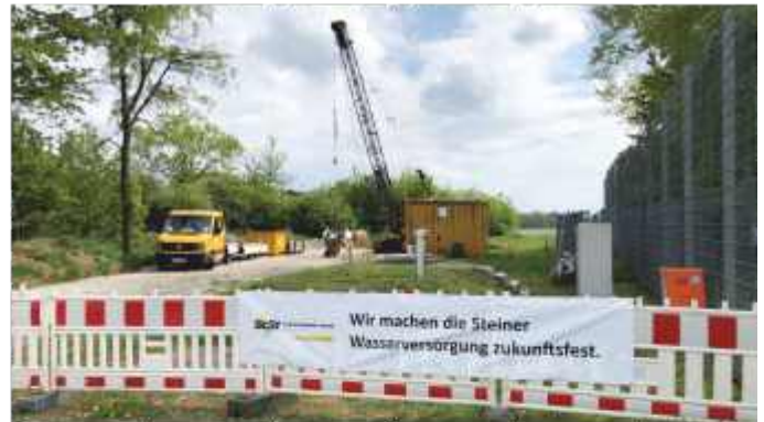
Rückbau Brunnen am alten Wasserwerk in Deutenbach.
