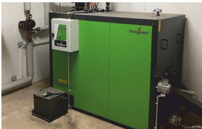
Heizöl war gestern. (Foto v.l.n.r.): Nahwärmerohe, Hackschnitzelkessel und Übergabetechnik zeugen von der aktiven Energiewende.
