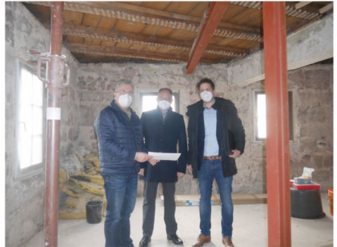
Baustellenbesuch im zukünftigen Kulturamt.
